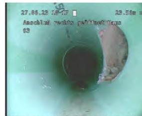
Bogengängiger Liner mit geöffneter Abzweigung
