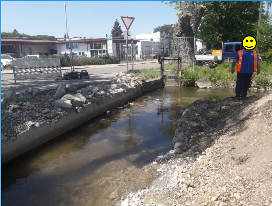
Abbruch Bestandsbrücke Mai 2018
