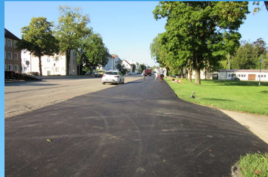
Nachher (Fahrtrichtung West)
