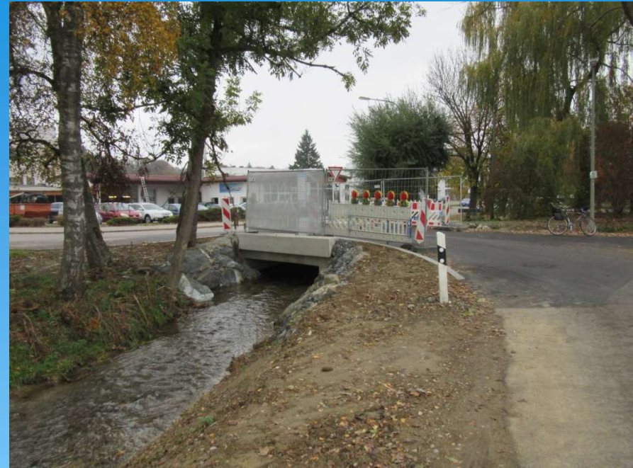
Zustand November 2018 – Geländer wird noch angebracht
